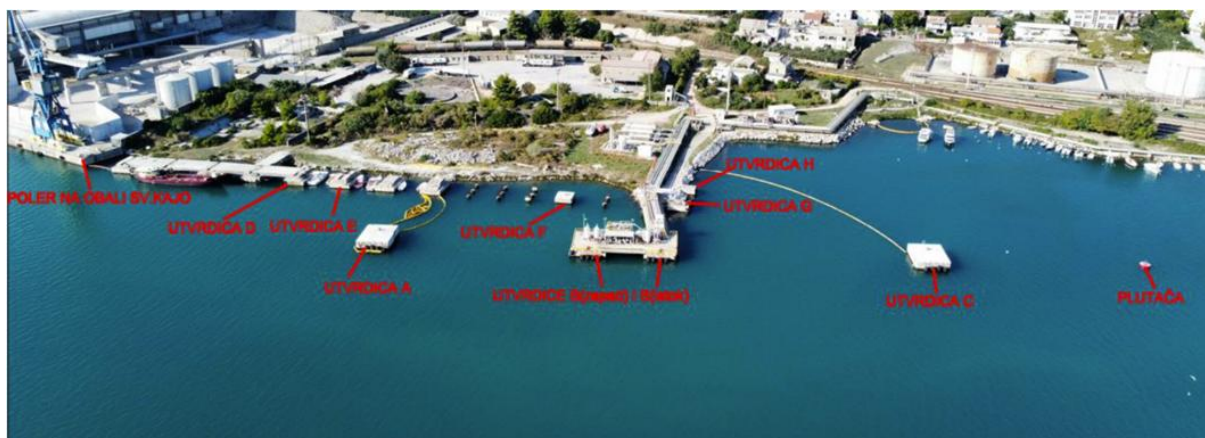
Slika 1. 1 - 2 Postojeće stanje utvrdica na lokaciji Kaštelanski bazen C (izvor: Idejno rješenje )
